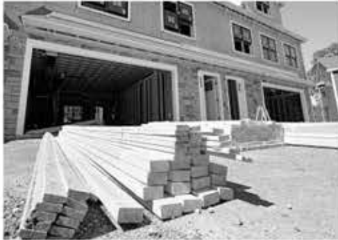
▲ 한 주택 건설 현장에 건축 자재들이 놓여있다. 사진=AP/뉴시스
