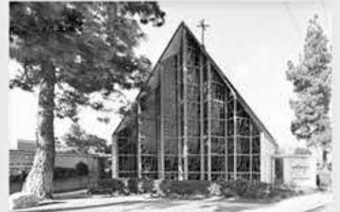
▲ 성공회가든그로브교회, 사진=구글 캡처
