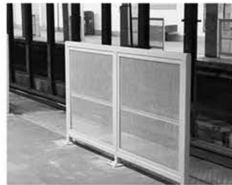
▲ 뉴욕 지하철 191번가역 플랫폼에 설치한 안전 차단막. 사진=X(APaolcell17)
