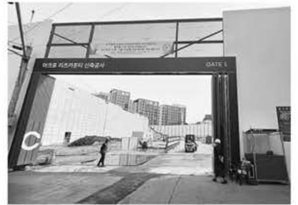
▲ 방배삼익 재건축 사업 부지. 사진=헤럴드경제
