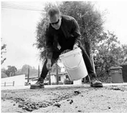
▲ 도로에 난 구멍을 메우고 있는 아널드 슈워제네거. 사진=인스타그램 캡처
