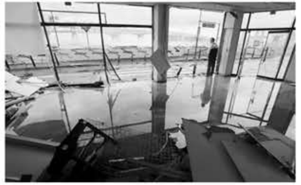
▲ 부산의 한 점포가 방파제를 넘어온 파도에 훼손됐다.
