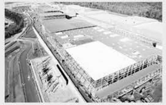
▲ SK이노베이션이 조지아주에 건설중인 전기차 배터리 공장. 사진=SK이노베이션
