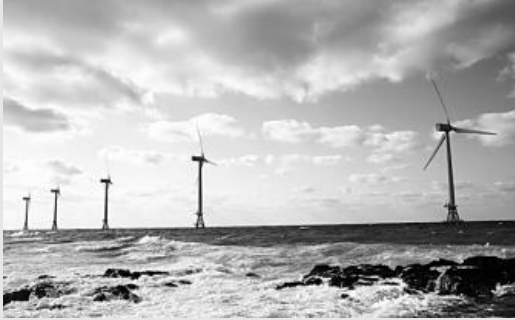
▲ 제주시 한경면 두모리와 금동리 앞바다에 위치한 탐라해상풍력발전단지. 사진=탐라해상풍력발전
