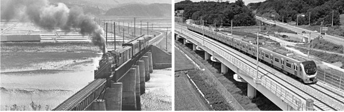
▲ 1978년 수인선 소래철교를 달리고 있는 협궤열차(왼쪽)와 복선화 된 표준궤도를 달리고 있는 수인선 전동열차. 사진=인천시립박물관, 한국철도시설공단
